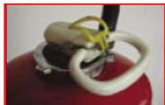
Feuerlöscher müssen gegen unbeabsichtigtes Betätigen gesichert sein. Die Sicherung muss auf jeden Fall zur Inbetriebnahme des Löschgerätes entfernt werden.
