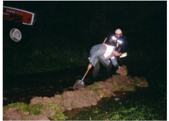
Kameraden beim Errichten eines kl. Dammes um die Wassermassen umzuleiten.
