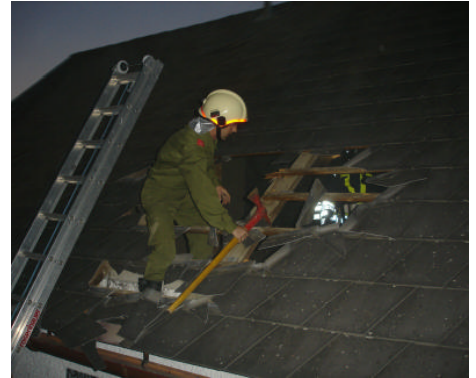
Kamerad beim Aufbrechen des Daches, um die Bergung der vermissten Person zu ermöglichen.
