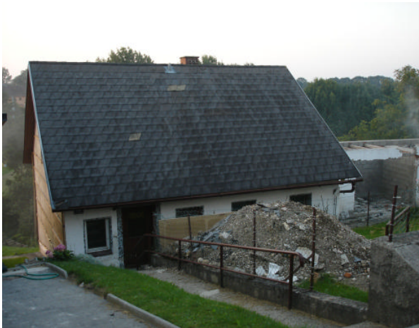
Das Objekt für die Großübung
