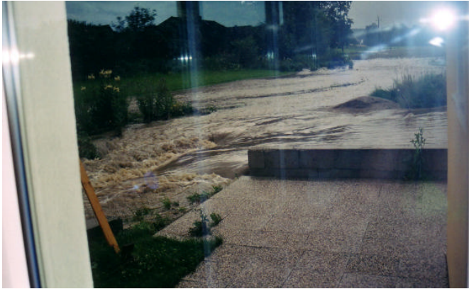
Ansicht vom Hauseingang aus, wo die Hauszufahrt komplett weggespült wird.
