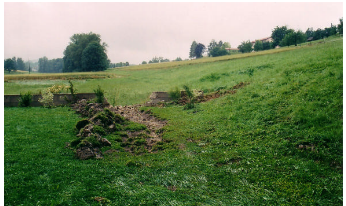
Am Tag danach: Hier ist ersichtlich wo die Gartenmauer weggestemmt wurde, damit die Wassermassen abfließen konnten.
